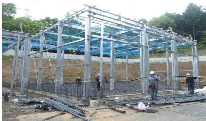
【写真④】洗車棟：鉄骨建て方工事
