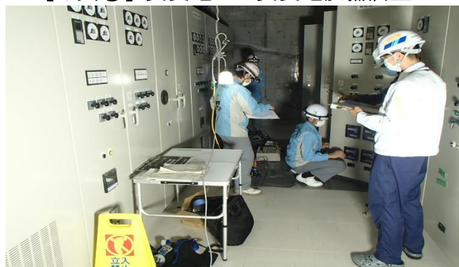
【写真②】受変電室：受変電設備調整
