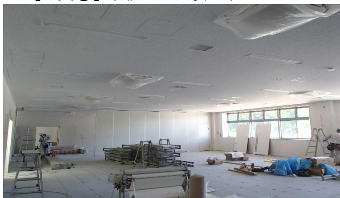
【写真①】研修室：内装工事
