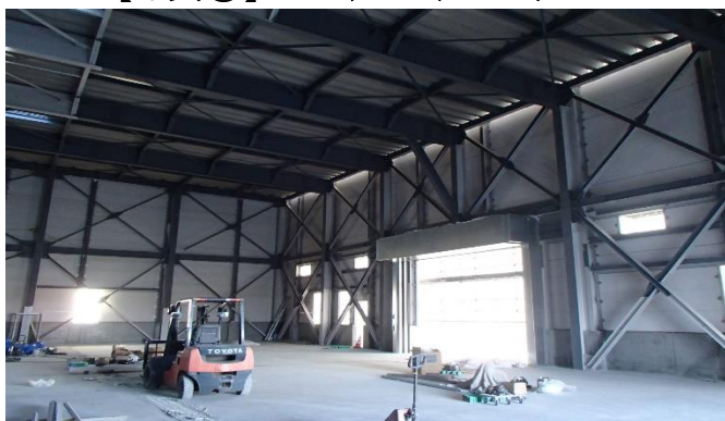
【写真①】A工区：外壁工事
