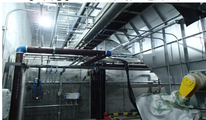
【写真②】C工区：配管・電気工事
