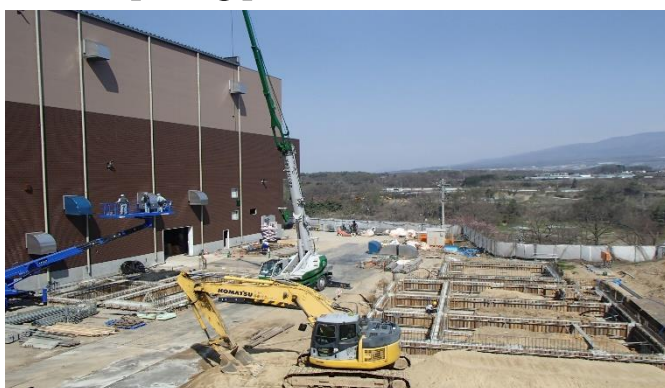
【写真④】付属棟：基礎工事
