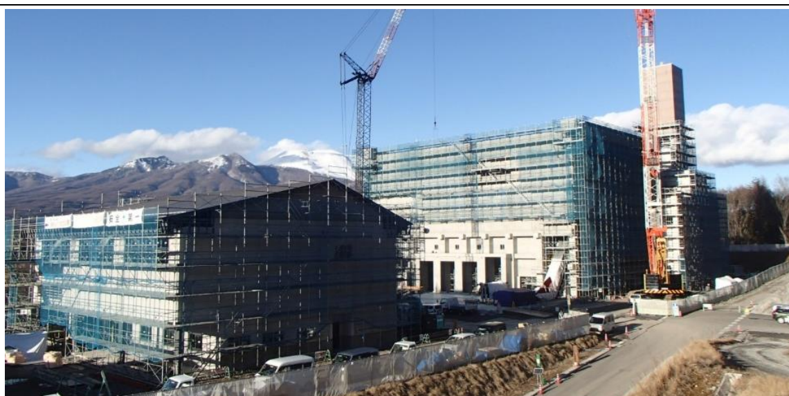
R2.1 撮影 施工状況
