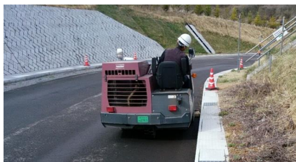
工事用車両出入り口の路面洗浄
