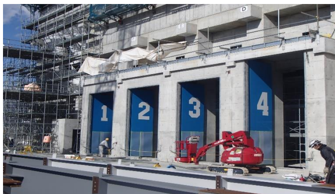
【写真②】B工区：投入扉設置
