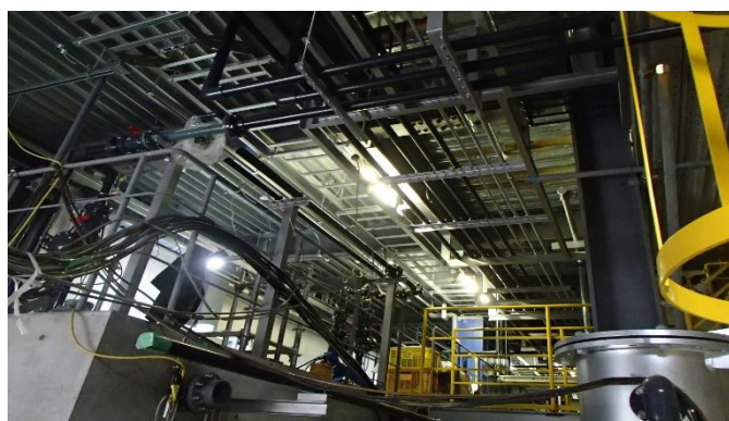
【写真④】C工区：配管工事
