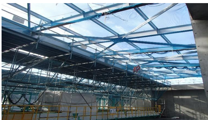
【写真③】B工区：屋根鉄骨組立
