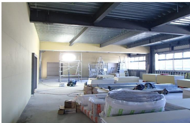
【写真①】事務所棟：研修室（内装工事）
