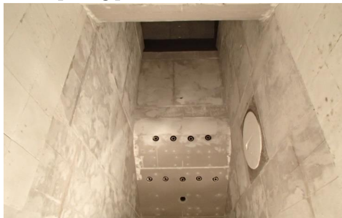
【写真④】C工区（焼却炉内部）
