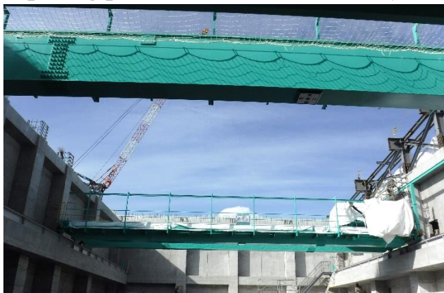
【写真③】B工区（ごみクレーンの設置）
