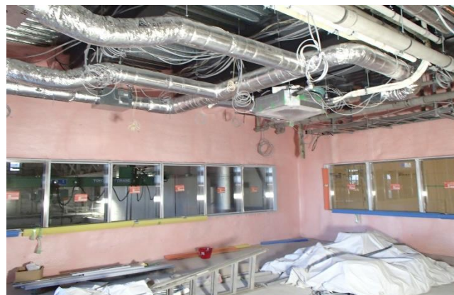
【写真②】B工区：見学者ルート（断熱工事）
