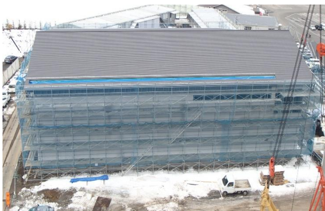
【写真①】事務所棟
