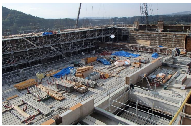
【写真④】ごみピット4階
