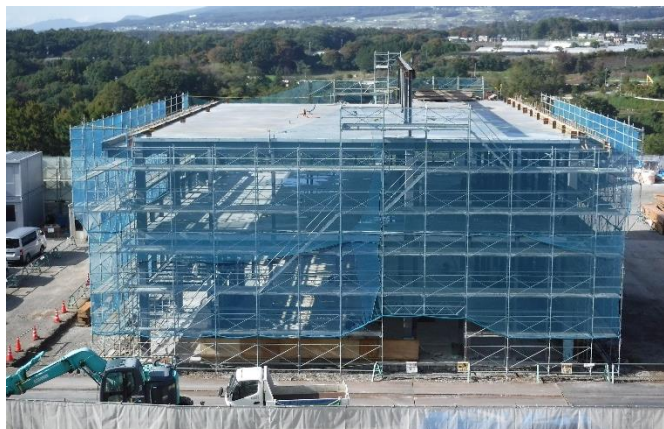
【写真①】事務所棟
