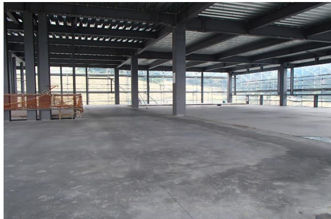
【写真②】事務所棟2階
