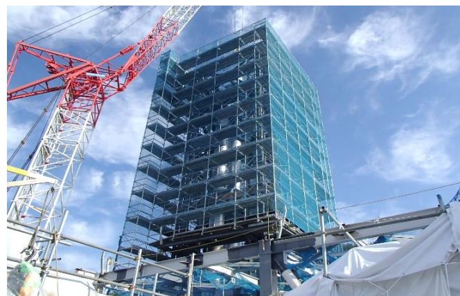
【写真⑤】D工区（煙突下部鉄骨+煙突内筒）
