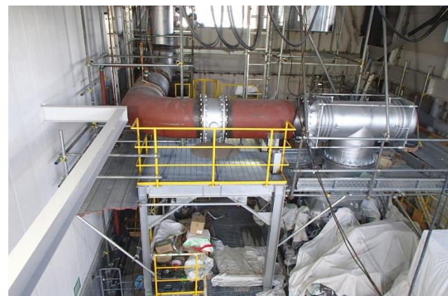
【写真⑥】E工区（蒸気排気管）
