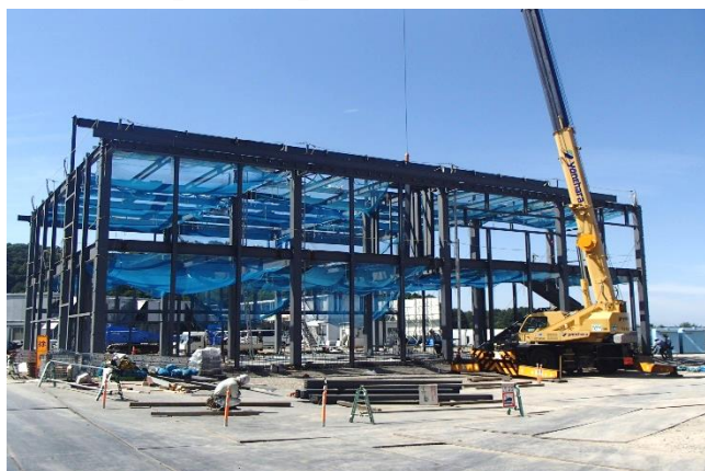
【写真①】事務所棟
