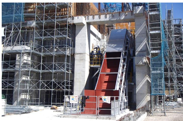
【写真③】B工区（粗大ごみ破碎設備）
