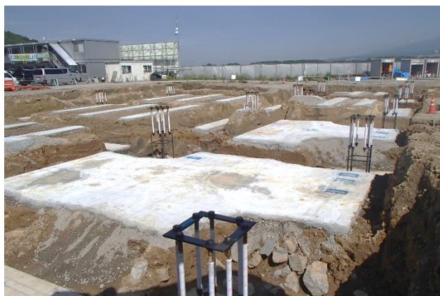
【写真①】事務所棟
