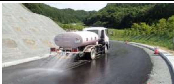
工事出入口の路面洗浄
