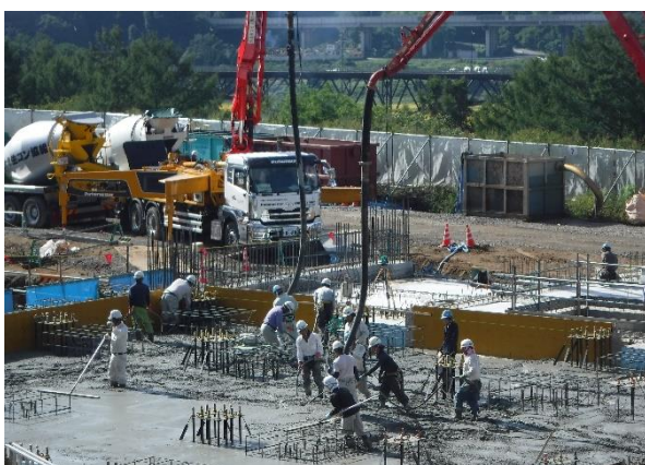
【写真③】 マットスラブ打込み
