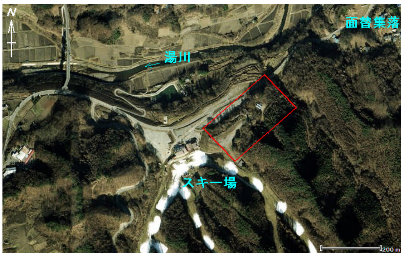
写真2. 1-2 調査地周辺の航空写真(赤枠内が業務箇所)
