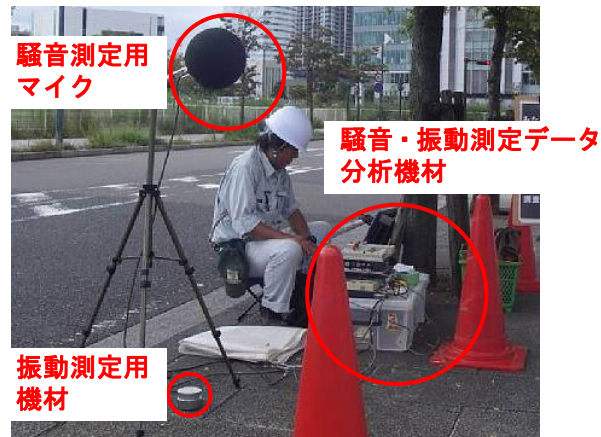
騒音・振動 調査機材
